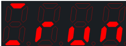
2#水泵运行(不使用互感器)
