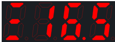
3#水泵电流值（单位：A）
