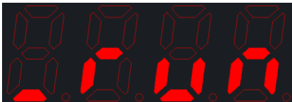
1#水泵运行(不使用互感器)
